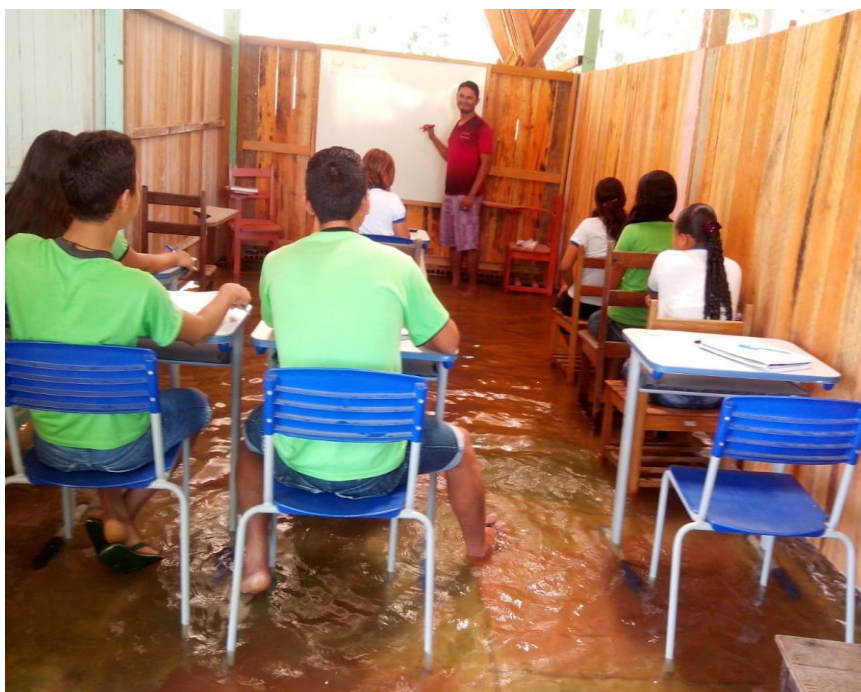
Foto 09 sala de aula inundada pela água da maré Fonte: Acervo do autor
